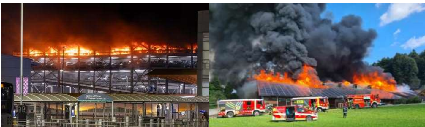
Slika levo: Požar parkirišča na londonskem letališču Luton, oktober 2023. Vir: The Guardian Slika desno: Požar strehe na kmetiji pod Šmarno goro, september 2023. Vir: Občina Medvode
